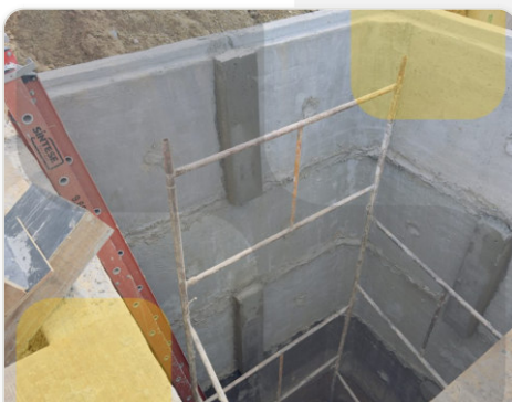
Poço de concreto em execução
