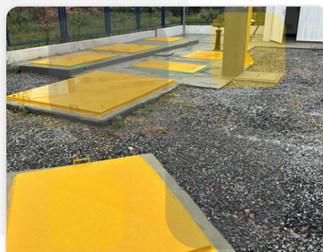
Tampas de acesso concluídas
