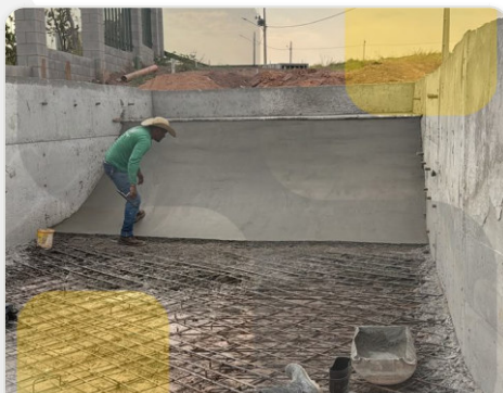
Concretagem da pista
