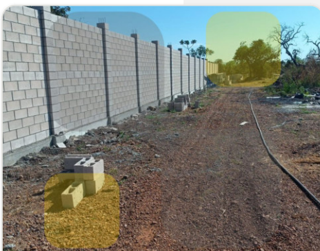
Trecho de muro
