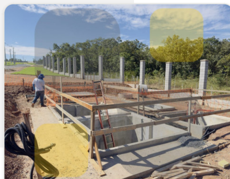
Estrutura do poço e escoramento
