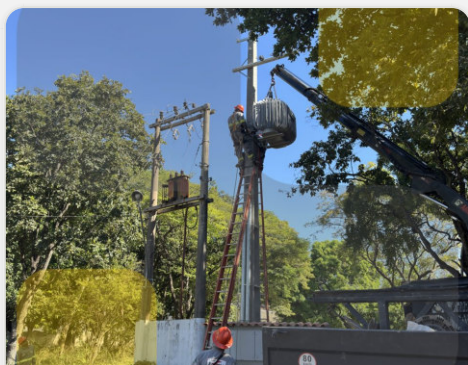
Içamento do transformador
