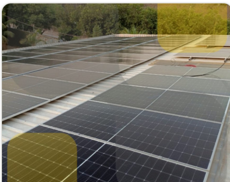
Módulos e estrutura de fixação
