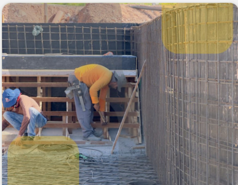
Fôrmas e armação das paredes
