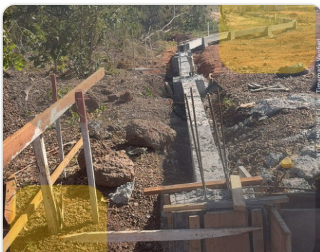
Fundação concretada
