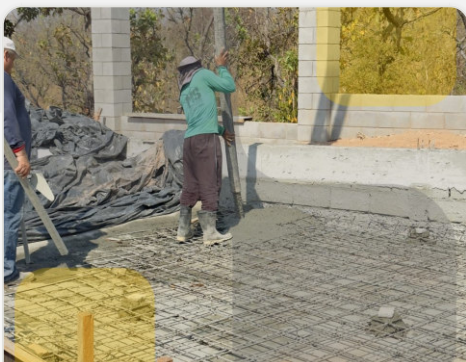
Concretagem da laje
