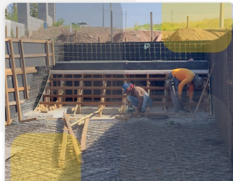
Fôrmas e armação: vista geral
