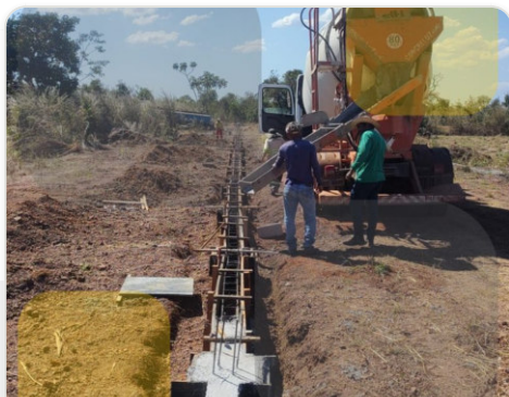
Concretagem de fundação
