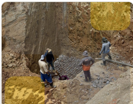
Escavação e preparo do poço
