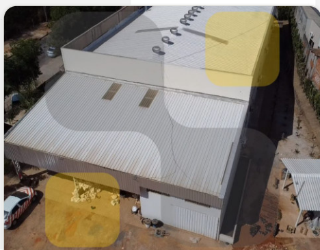
Vista aérea da edificação, durante a obra
