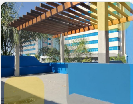
Pergolado da área reformada
