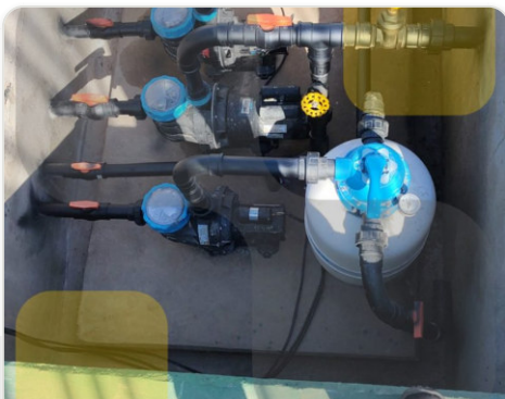
Casa de máquinas
