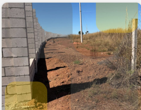
Trecho de muro
