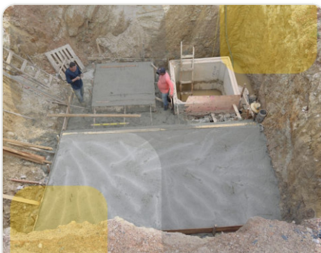
Lajes concretadas
