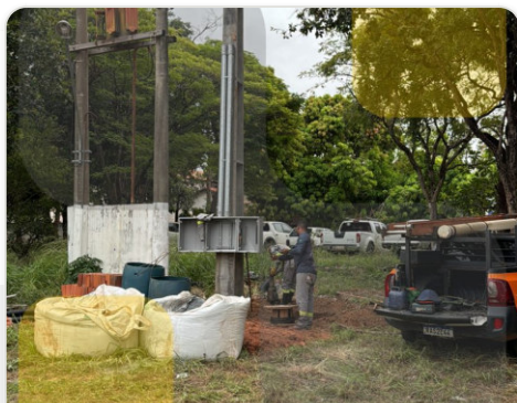
Posto de transformação: local da obra
