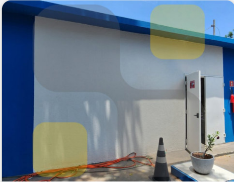
Cabine da subestação
